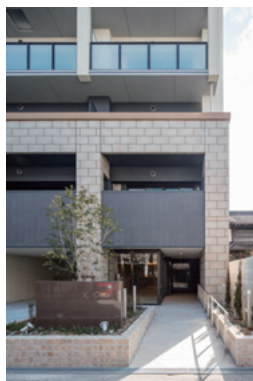
〈スロープ・手すり〉
