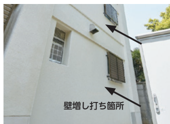
〈耐震増し打ち壁〉
