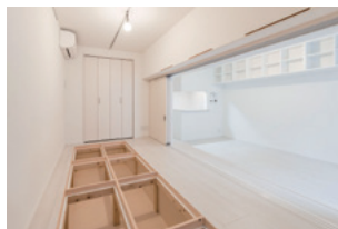
〈逆梁工法を利用した床下収納〉
